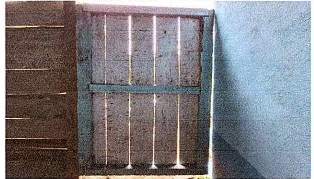
Foto 2: sustitucion de puerta de metal
